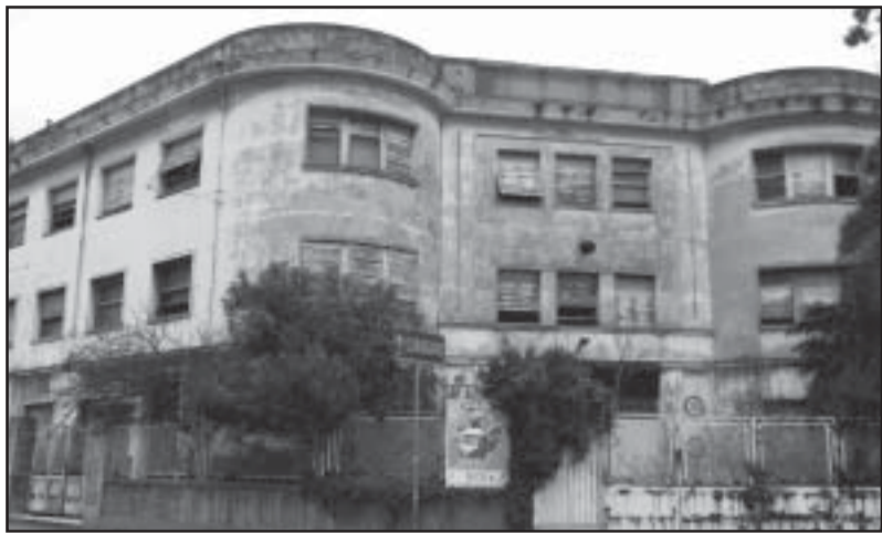
L'ex area Mira Lanza dove doveva sorgere l'ospedale di Vallata
