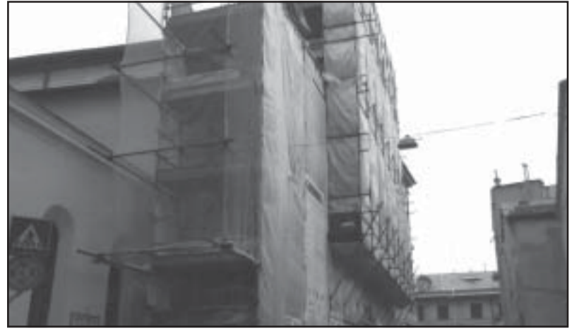
I lavori di pulizia alla facciata della chiesa della Cella
